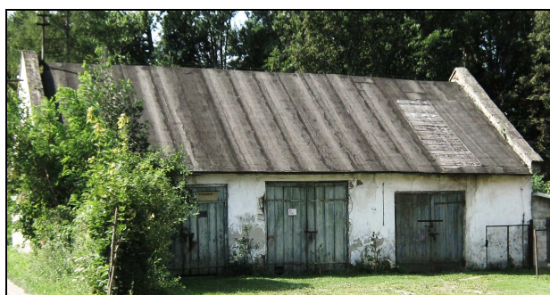
Budynek warsztatu kamieniarskiego (II nr rej. 1000 opisany w pkt. 3)
