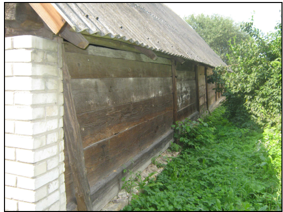
Prawęcín nr 48 - zachowana zabudowa w typie „okólnika” Od frontu dom drewniany datowany na około 1890 r. połączony bramą przejazdową z oborą drewnianą, konstrukcji słupowej, wzmocniona współczesną ścianą szczytową z cegły silikatowej
