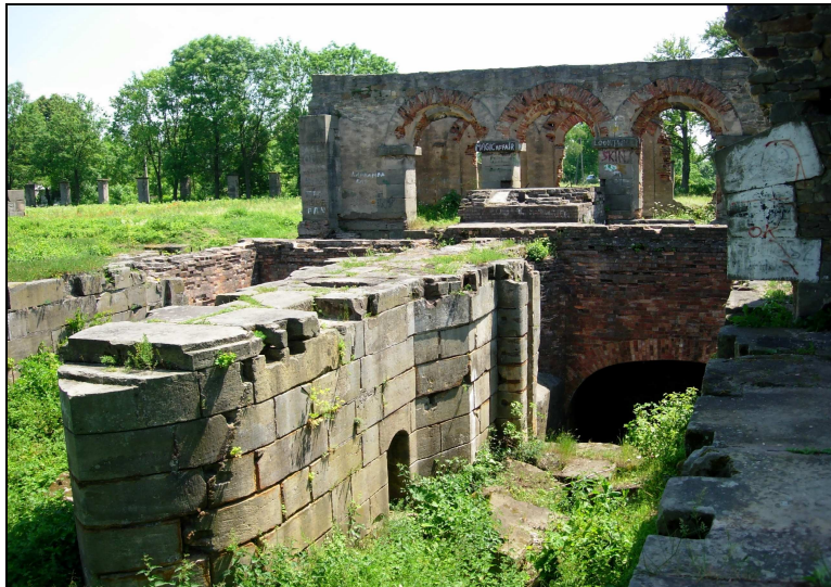
Kanał prowadzący wodę do turbin.
