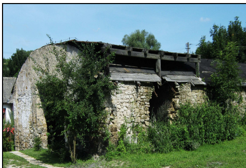
Budynek warsztatu kamieniarskiego (I, nr rej. 1000 (opisany w pkt. 2)
