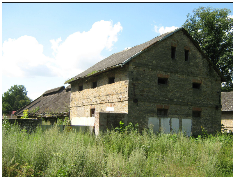
Przykład jednego z lepiej zachowanych budynków fabrycznych (młyn) z 1885 r.
