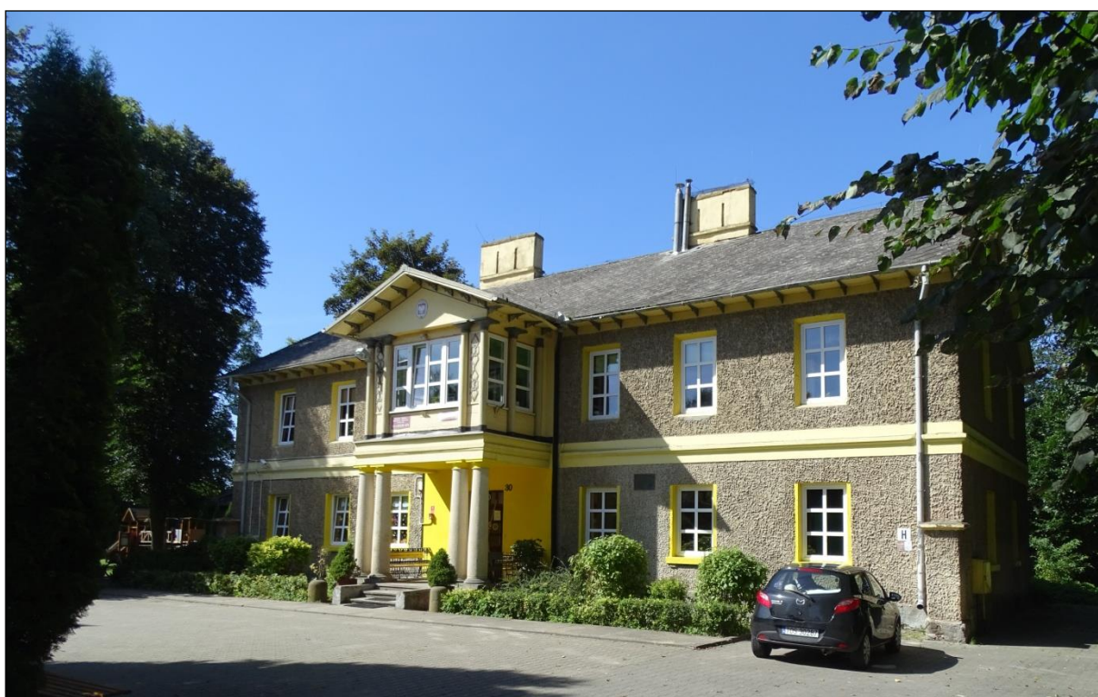
Budynek dyrekcji (zarządu) zakładu, ob. szkoła
