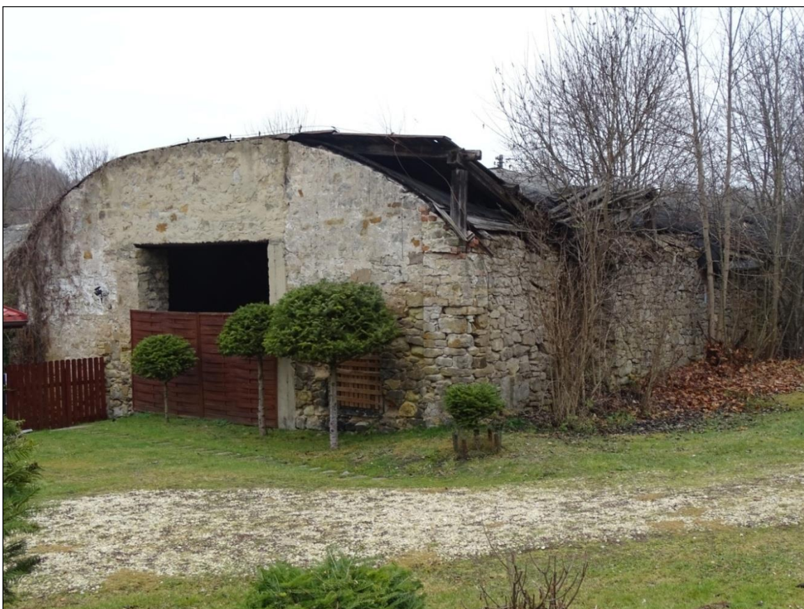
Warsztat kamieniarski zw. Wrocławiem, późniejsza suszarnia i magazyn makulatury
