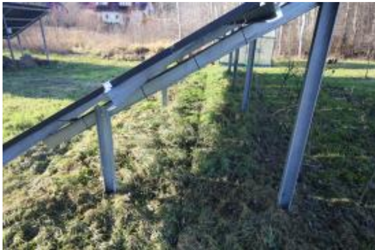
Fotografia 10. Teren pomiędzy i pod panelami nie jest utwardzony [źródło: własne archiwum]
